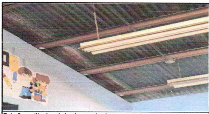
Foto 5: sustitucion de lamina por lamina troquelada calibre 26, y sustitucion de de soporte de metal por metal
