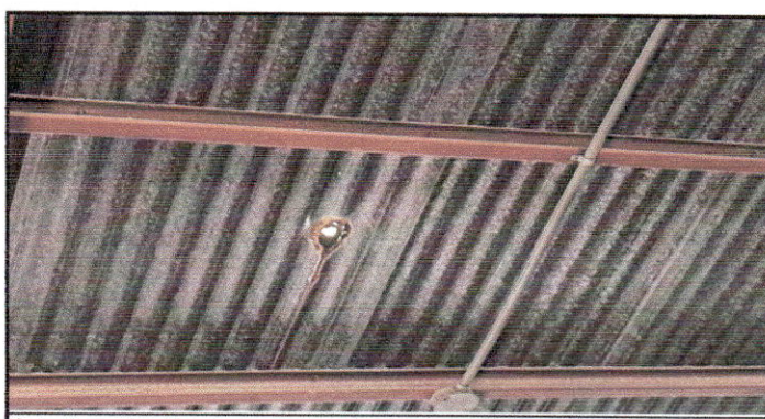
Foto 6: sustitucion de lamina por lamina troquelada calibre 26, y sustitucion de de soporte de metal por metal
